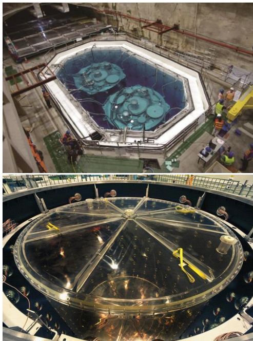
图 24.12 大亚湾中微子实验站 1 号实验厅实景图（左），正在组装的中心探测器（右），由大亚湾国际合作组提供。
